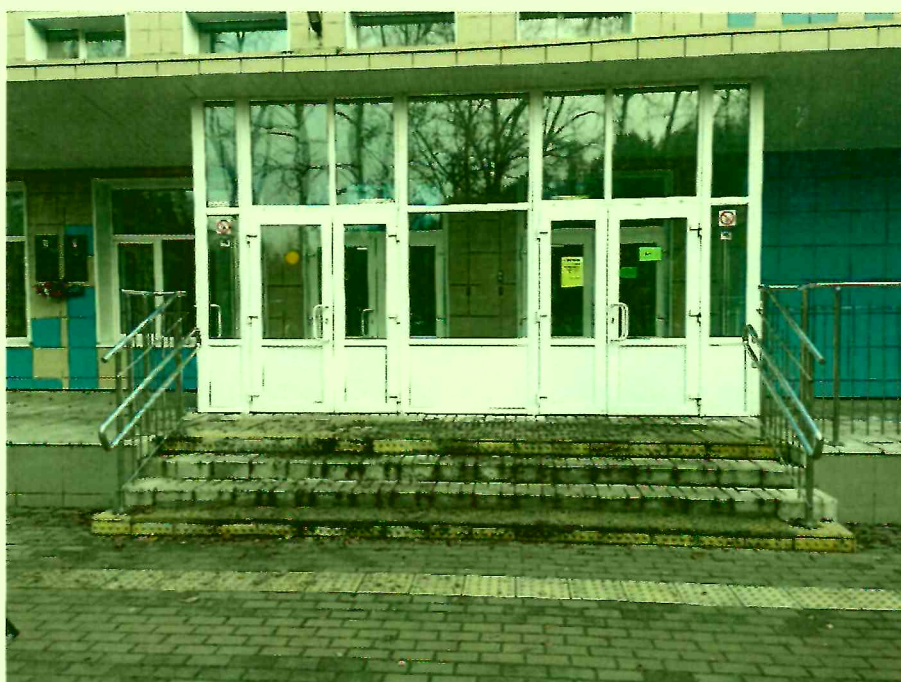
Фото № 4 Дверь (входная)
